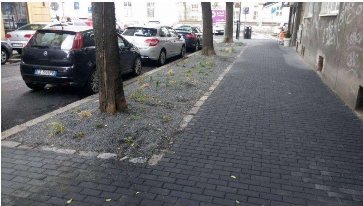
Kúpeľná ulica po rekonštrukcii (nový povrch, priestor pre zeleň)
