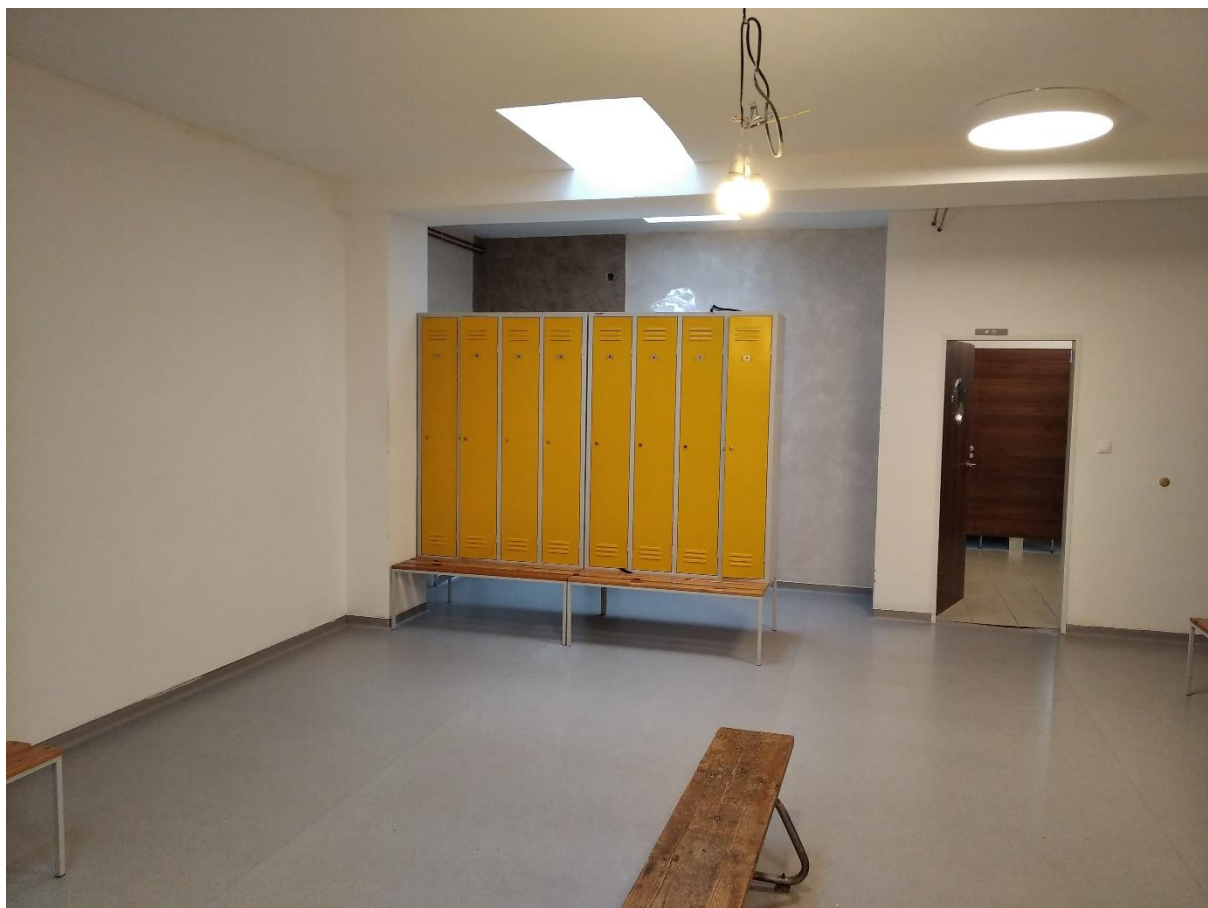
Zrekonštruované šatne a sociálne zariadenia
