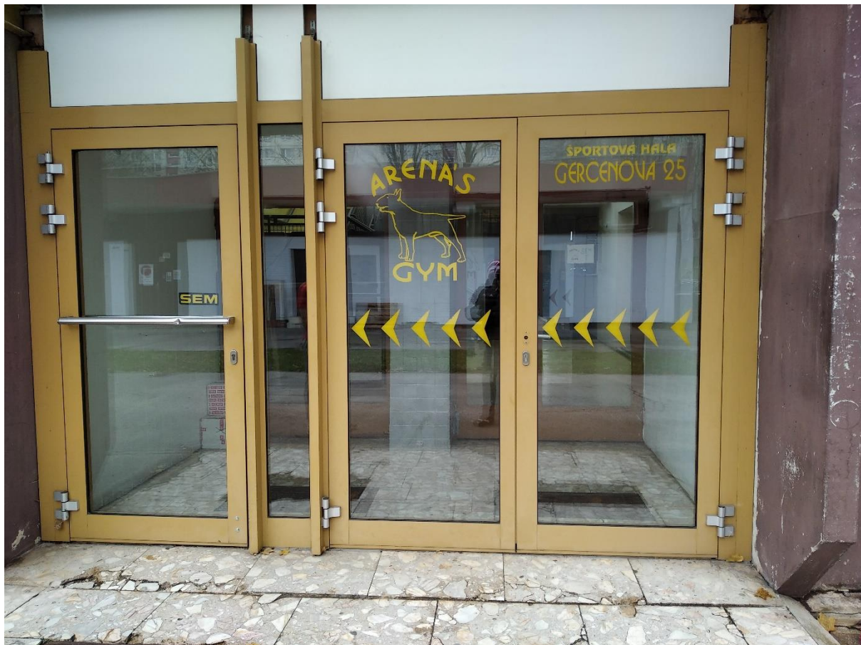
Južná strana budovy – nové vchodové dveře
