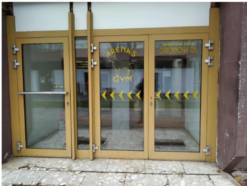
Južná strana budovy – nové vchodové dveře
