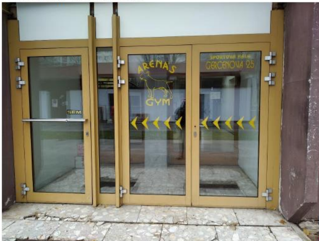
Južná strana budovy – nové vchodové dveře
