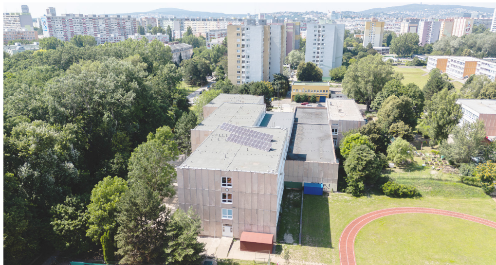
Fotovoltaické zdroje umiestnené na ZŠ Černyševského a ZŠ Dudova (na snímke) budú zdieľať elektrinu s inými odbernými miestami mestskej časti. | Foto: Ivana Vrablová
